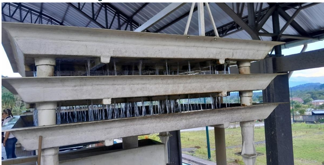
Fotografía 53. Planta de tratamiento de Jimbitono.
