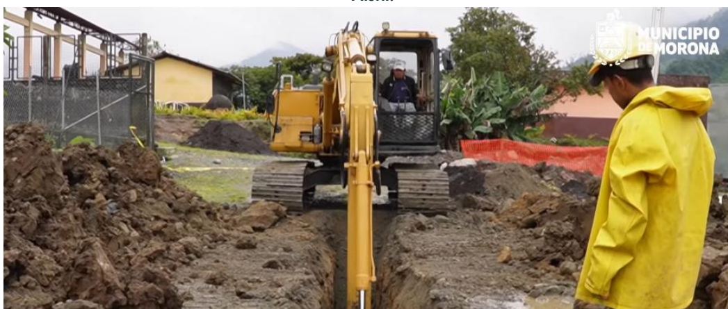
Fotografía 56. Trabajos de los sistemas de alcantarillado sanitario y pluvial del centro parroquial de Alshi.
