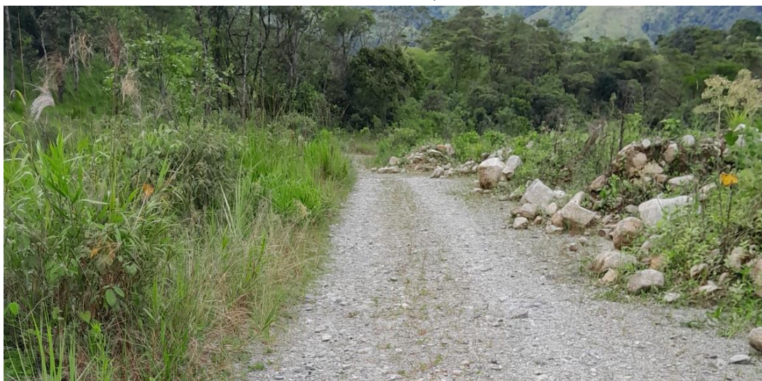
Fotografía 3. Camino vecinal de ingreso a la planta de tratamiento de agua potable, en la parroquia 9 de Octubre,
