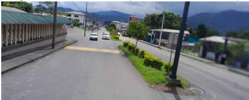
Fotografía 6. Tramo de la Avenida 29 de Mayo, en el sector del Cementerio Municipal.
