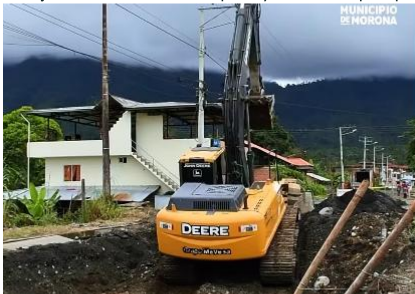
Fotografía 58. Trabajos de la red de alcantarillado pluvial y sanitario de la parroquia de San Isidro.
