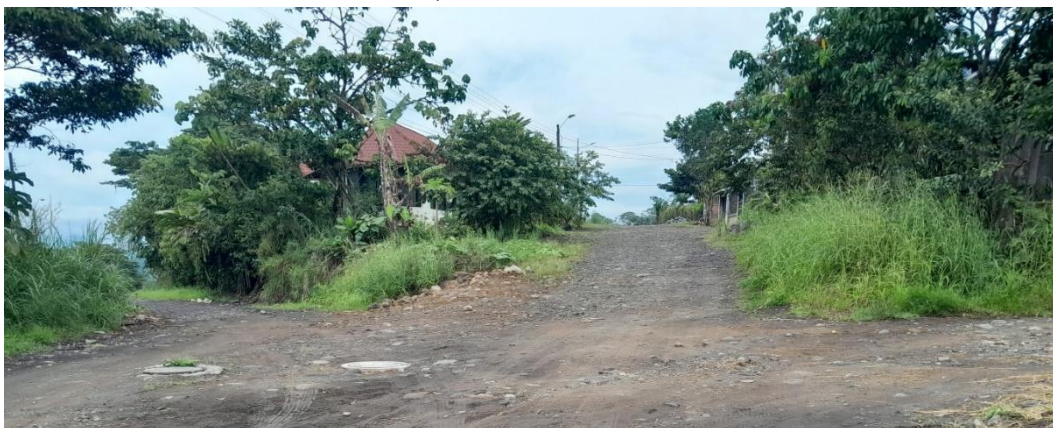
Fotografía 17. Vías en lastre, tierra, en la intersección de las vías: Marina Madero, Ramon Navarrete y Peatonal MP 611, en dirección al sur de la ciudad.
