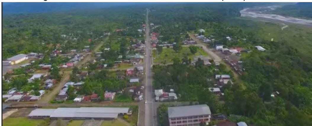
Fotografía 23. Vista aérea de la red vial de la cabecera parroquial de Sinaí.
