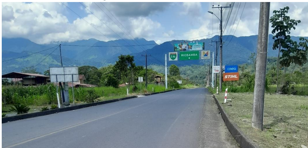
Fotografía 1. Vía E46, Macas – Guamote.
